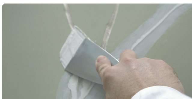
■ Fisuras superiores a 2 mm tratadas con masilla elástica
